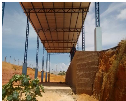
Figura 7.5 – Nova Área de Transbordo de Resíduos sendo realizada
