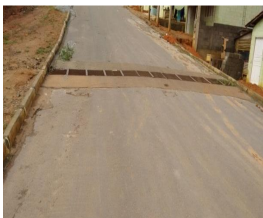
Figura 8.5 – Drenagem em Namytyala
