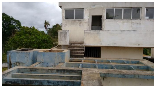
Figura 5.38 – Vista ETA Garrafão
