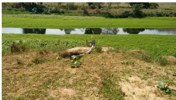
Figura 5.45 – Ponto de Captação ETA São João da Lancha
