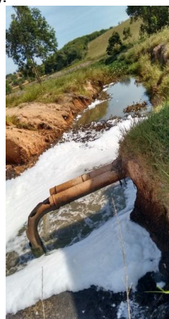
Figura 6.4 – Córrego Ilmenita - Ponto de Lançamento
