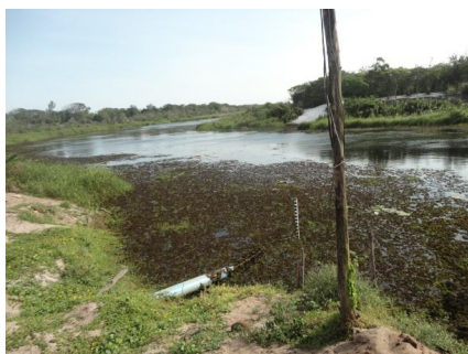
Figura 5.15 – Captação de Água Bruta na Lagoa Guanandy
