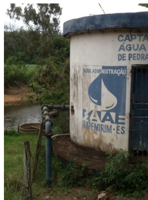
Figura 5.31 – Detalhe da Captação
