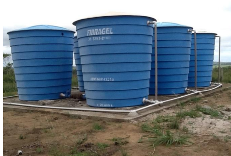
Figura 5.34 – Reservatórios ETA Pedra Rio Muqui
