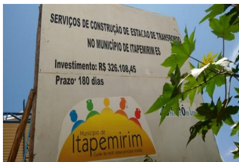
Figura 7.7 – Placa de Informações referente a Obra realizada
