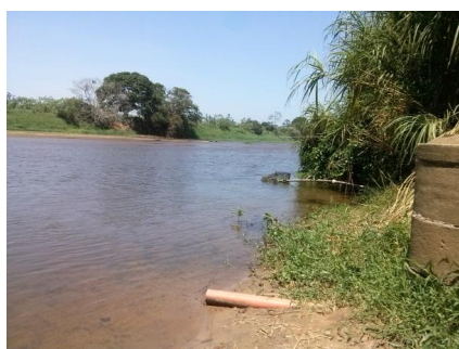
Figura 5.26 – Captação da ETA Limão no Rio Itapemirim
