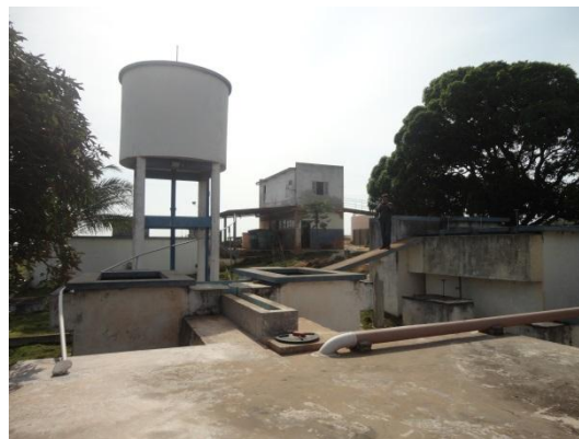
Figura 5.19 – Vista da ETA Gomes
