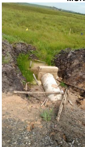
Figura 8.11 – Drenagem Campo Acima Fonte: Projeta Engenharia, 2015.
