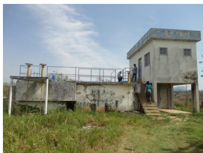
Figura 5.46 –ETA São João da Lancha
