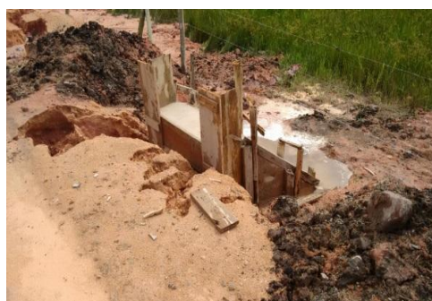
Figura 8.12 – Drenagem Campo Acima Fonte: Projeta Engenharia, 2015.
