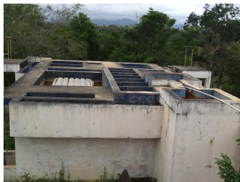
Figura 5.33 – Vista de Cima ETA Pedra Rio Muqui
