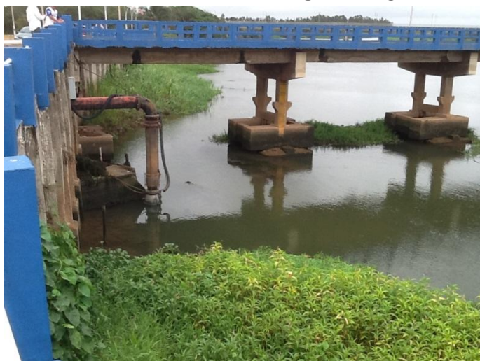
Figura 5.1 – Captação Principal no Rio Itapemirim
