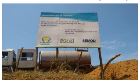
Figura 5.24 – Placa Referente Implementação de Melhorias no Sistema de Abastecimento de Água
