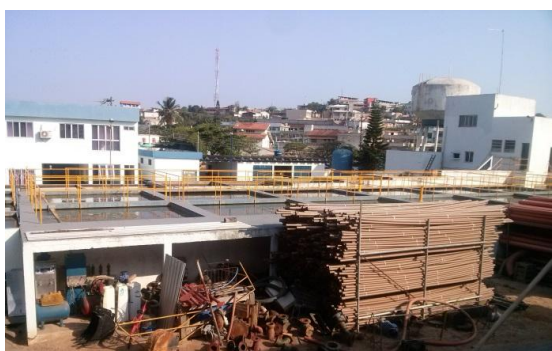
Figura 5.5 – Vista ETA Principal
