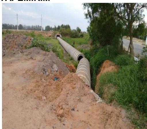
Figura 8.4 – Manilhas sendo instaladas na obra de drenagem do Jardim Paulista
