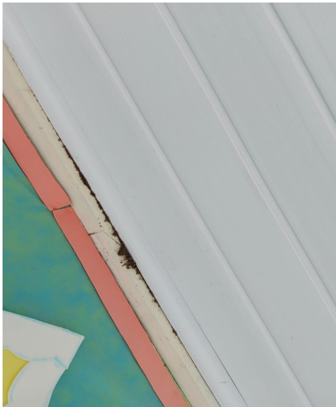
FORRO DA VARANDA DA CRECHE
