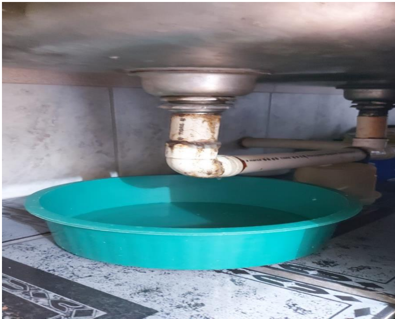
ENCANAMENTO DA PIA DA COZINHA
