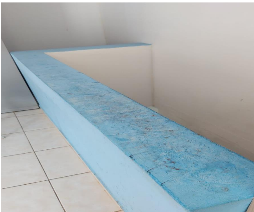
MURETA DO SEGUNDO PISO PARA COLOCAR A PEDRA DE GRANITO (FAZER BANCADA)
