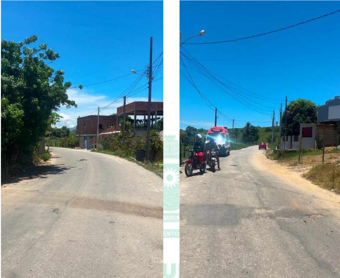
REGISTRO DE IMAGENS DO LOCAL PARA CONSTRUÇÃO DA LOMBADA (QUEBRA-MOLA).
