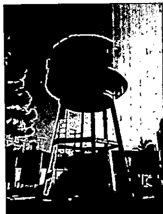
Figura 5.9 – Reservatório para Lavagem dos Filtros
