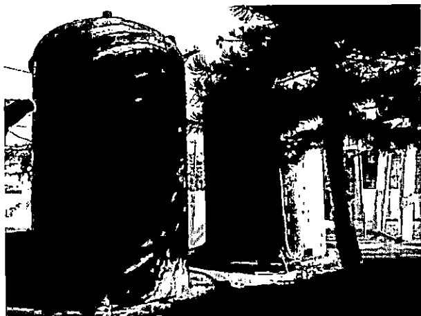
Figura 5.7 – Reservatório de Sulfato de Alumínio
