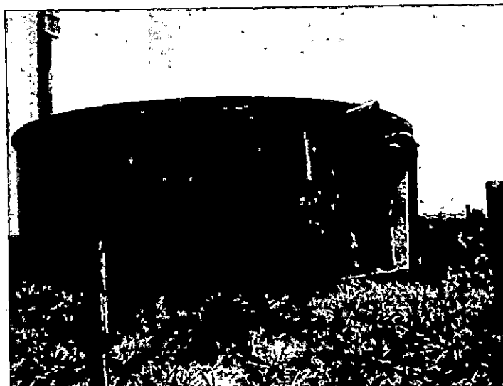
Figura 5.4 – Reservatório Utilizado para a Distribuição de Água na Sede de Itapemirim
