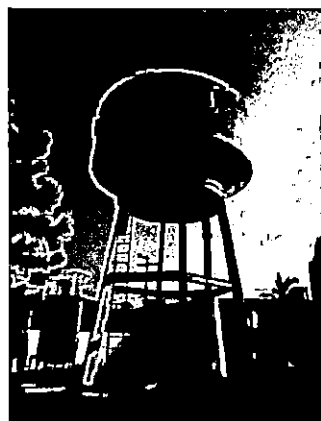
Figura 5.9 – Reservatório para Lavagem dos Filtros
