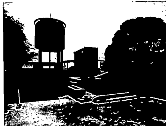
Figura 5.19 – Vista da ETA Gomes
